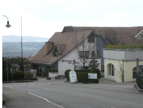
Abbildung 37: li.: Bauamt/magazin/Werkhof; re.: Wirtschaft zum Stutz
