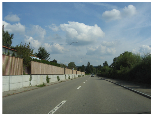
Abbildung 15: li.: Imbismattstrasse; re.: Lärmschutzwände Bellikonerstrasse
