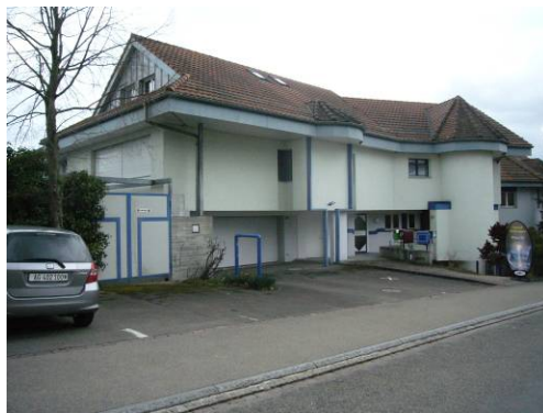
Abbildung 44:li.: typisches Einfamilienhaus in der Rüti, re.: Bauten an der Dorngasse
