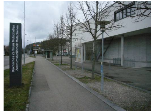
Abbildung 22: li.: Altersheim mit Pflanzerbach, re: Vorbereich KIBIZI/ Reformierte Kirche
